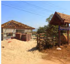
建設中の保健センター
