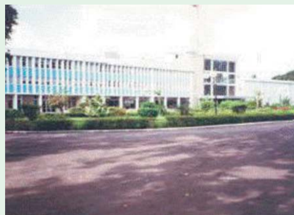
AFROの敷地（入口付近）
